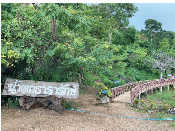
5) ป้ายน้ำตกและทางเดินชมทิวทัศน์คอนกรีต
