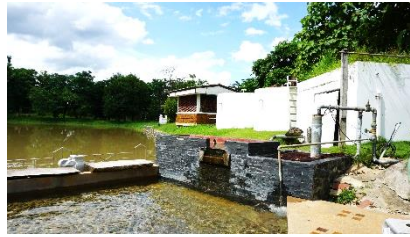
รูปที่ 30 อาคารปั๊มน้ำและ ถังเก็บน้ำร้อนที่อยู่ติดกับบ่อน้ำ
