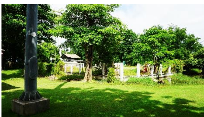
รูปที่ 28 รั้วที่ชำรุดเสียหายซึ่งกั้นระหว่างพื้นที่ ภายในกับพื้นที่โล่งที่มีสิ่งปลูกสร้าง เกี่ยวกับระบบประปา
