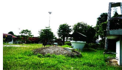
รูปที่ 29 สภาพพื้นที่ขาดการดูแล ภายในพื้นที่โล่ง ที่มีสิ่งปลูกสร้างเกี่ยวกับระบบประปา
