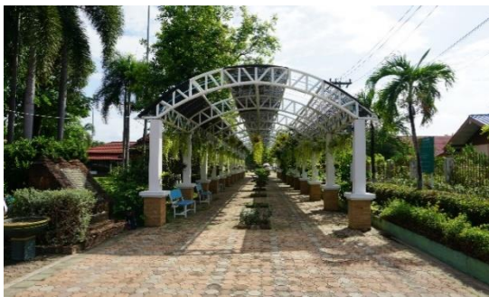
รูปที่ 53 ทศนียภาพบริเวณชุ่มทางเดินด้านหน้าก่อนปรับปรุง (มุมมอง G)
