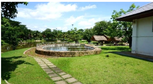
รูปที่ 43 ทศนียภาพบริเวณบ่อกำเนิดน้ำพุร้อน บ่อที่ 2 ก่อนปรับปรุง (มุมมอง C)
