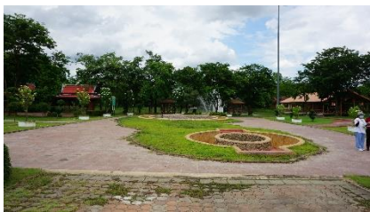
รูปที่ 26 เส้นทาง และขอบบ่อพุร้อน เป็นคอนกรีตผิวกระด้าง
